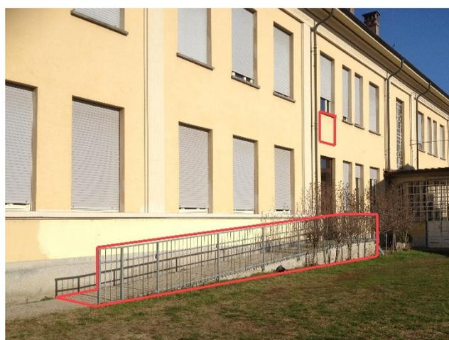
*Sud - Demolizione rampa pedonale e parapetto finestra (rosso)*
